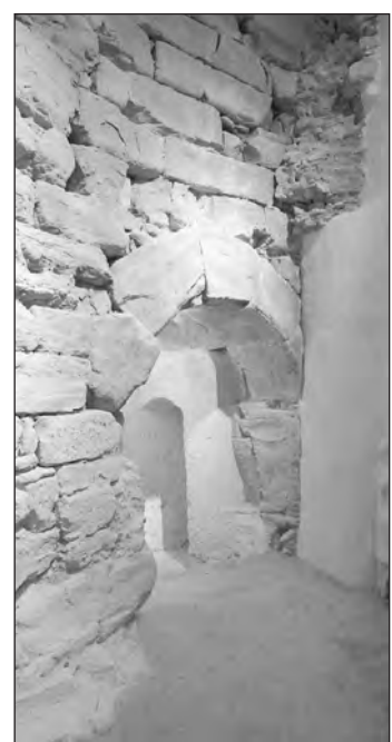
Muro palazzo Casali
