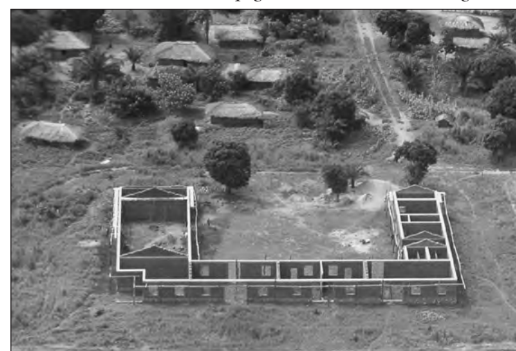
L'edificio scolastico in costruzione visto dall'aereo al momento dell'atterraggio (foto Patrizio Sorchi)
