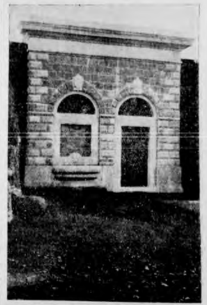
Camera di manovra del nuovo acquedotto
