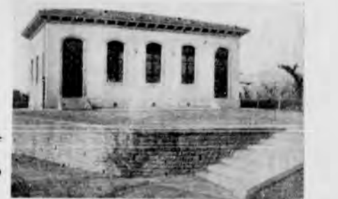
Edificio scolastico a Montanare
