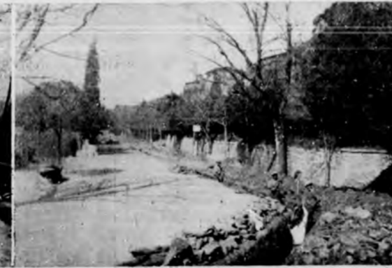
La posa dei tubi lungo i Giardini Pubblici
