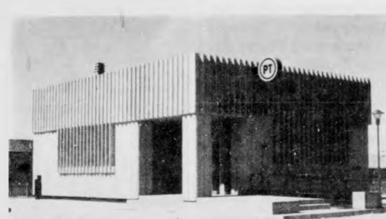
MARZO - Le Poste da tempo hanno iniziato un'opera di rinnovamento delle proprie strutture murarie. Anche a Terontola nel mese di marzo viene inaugurato il palazzetto delle Poste e Telecomunicazioni che era stato iniziato nel novembre 1987, l'inaugurazione avviene il Venerdì Santo. La localizzazione è ottimale perché vicino alla stazione in una posizione strategica di Terontola. Attorno una vasta area da adibire a posteggio.
