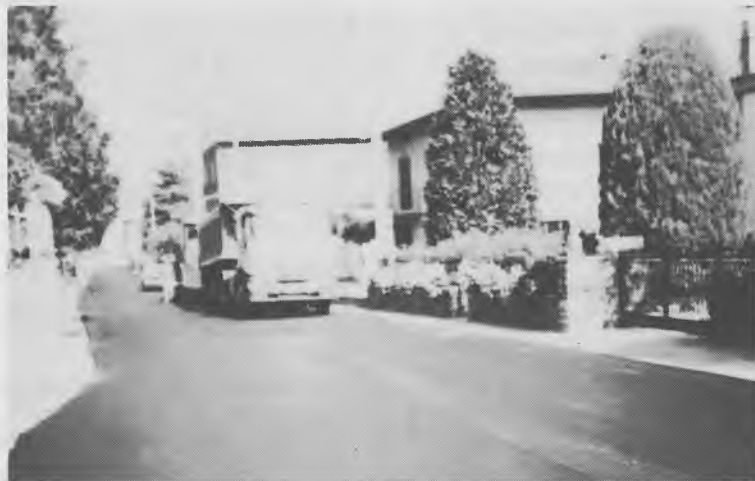
Nella foto: Il nuovo asfalto di via Pietro da Cortona
