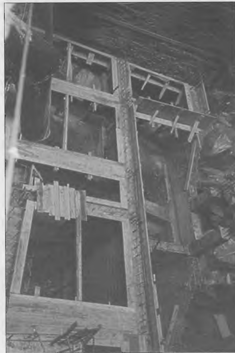
La struttura in cemento armato vista dall'alto del cortile.
