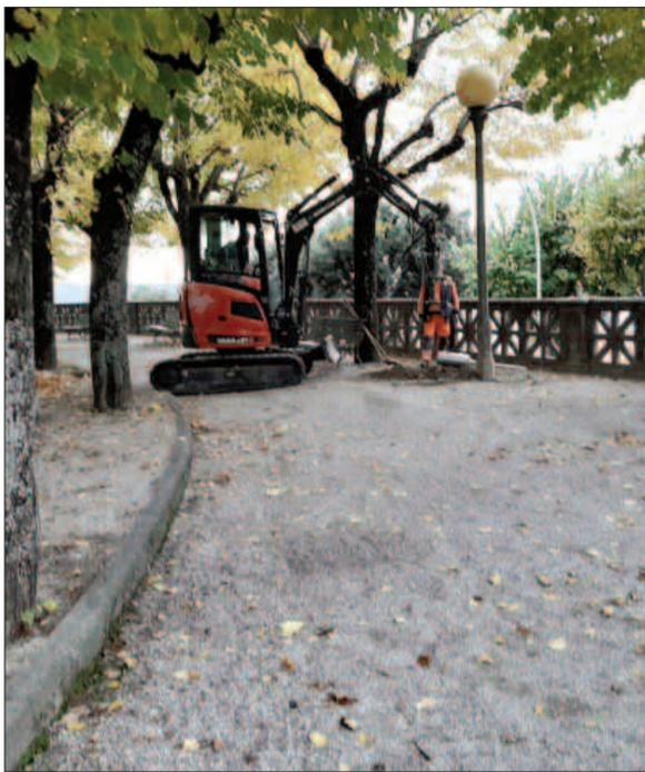
anche della tutela della sicurezza dei cittadini. La riqualificazione consiste nel rinnovo totale delle linee elettriche interrato, con la sostituzione integrale della vecchia rete esistente e la conseguente messa a norma dell'impianto, in base alle nuove disposizioni di legge.
