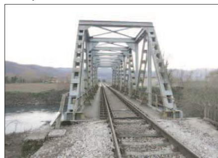
... davanti a noi la sagoma scura di un lungo ponte in ferro...
