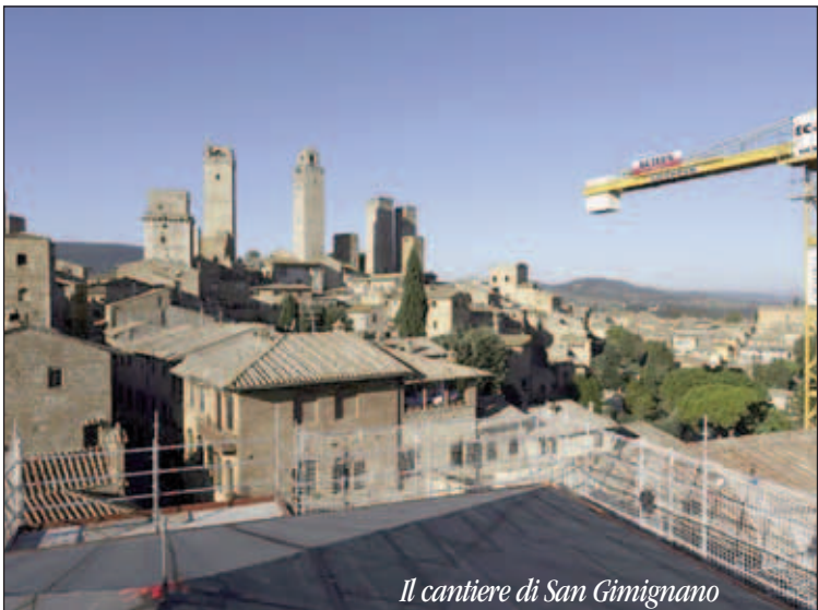
Il cantiere di San Gimignano
