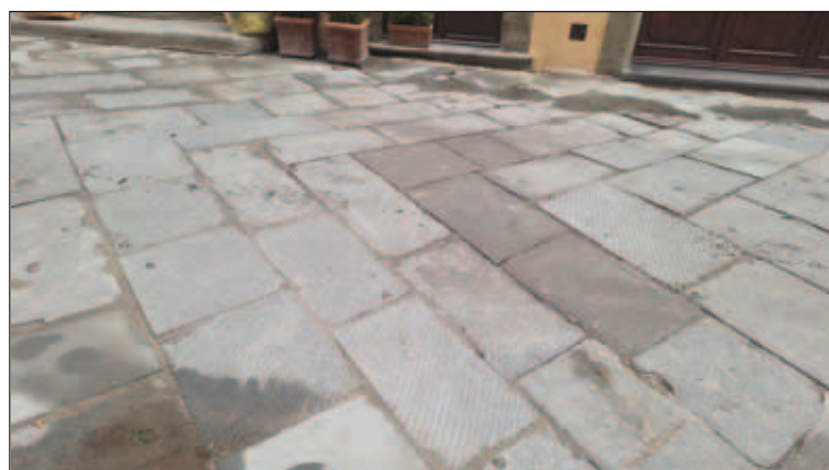
Lastricato di Via Nazionale come è attualmente
