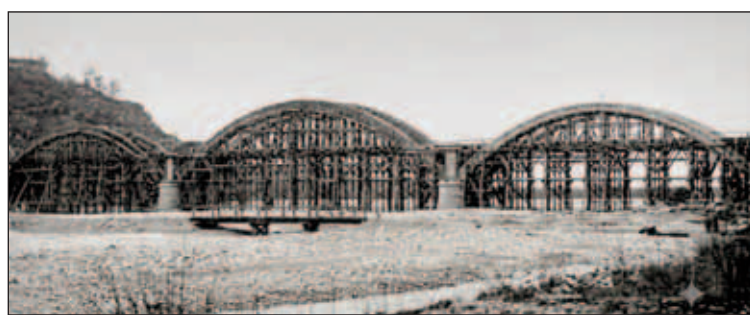
Sequals (PN), Ponte sul fiume Meduna in fase di ricostruzione dopo le distruzioni belliche (Aprile 1921)
