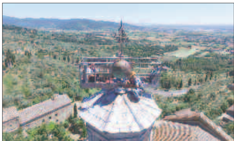
Il complesso monumentale del Calcinaio con i tecnici delle ditte di Cortona, Carlini Restauri Costruzioni e Cortona Ferro
